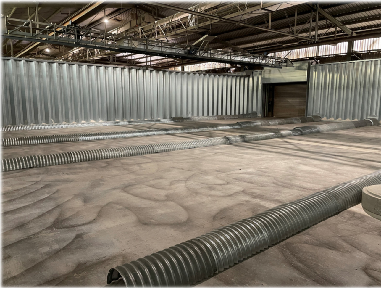
Box mit Stahlwänden und Panzertopkanälen ÖKN Bad Bevensen
